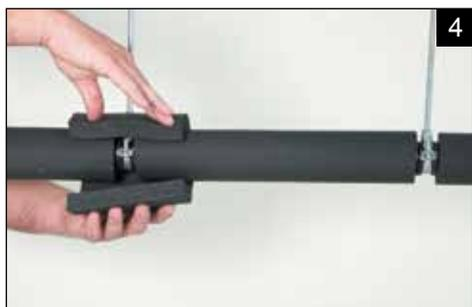
Смонтировать полосу и заклеить продольный шов и вертикальный надрез для крепежного болта специальным клеем KAIFLEX.
