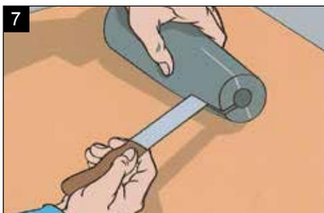
Смонтируйте деталь на трубопроводе. Склейте места разреза детали и места ее соединения с другими участками теплоизоляции.
