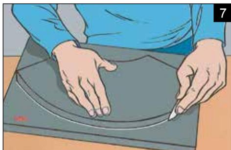
Разместите полученную деталь на лист теплоизоляции и, используя ее как образец, вырежьте еще одну деталь.
