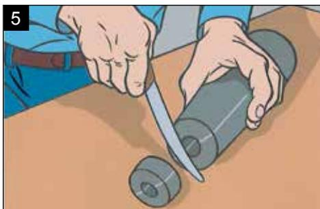
Отрежьте край детали большего диаметра по размеру недостающего отрезка изоляции.
