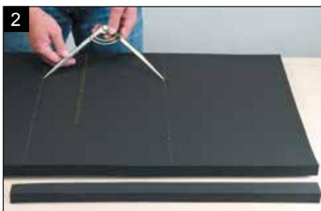
Отметить внешний и внутренний изгиб угла трубы на материале, затем с помощью циркуля (расстоянием половины периметра) круговыми дугами соединить будущие линии разреза.
