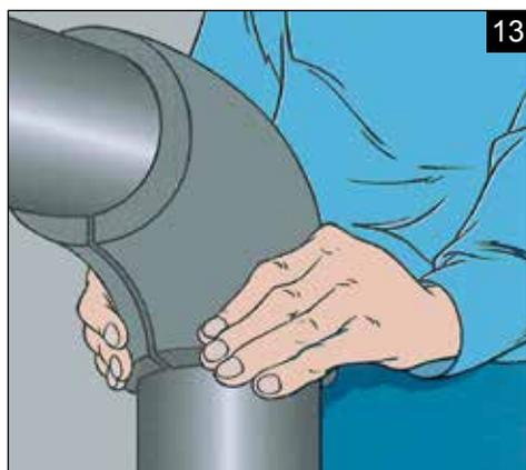
Смонтируйте теплоизоляцию на изгибе трубопровода и склейте по малому радиусу.
