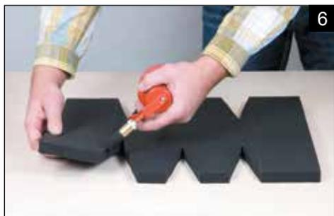
6 Далее нанесите клей KAIFLEX на внутренний контур каждого угла и дайте подсохнуть.
