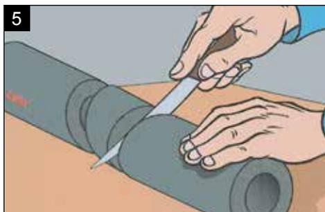
Разверните крайние отрезки теплоизоляции, как показано на рисунке.
