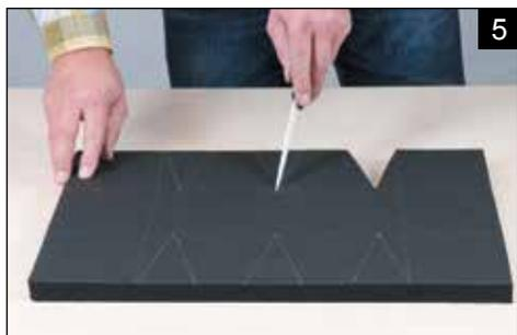
5 С помощью маркеров нарисовать, а затем вырезать ножом KAIFLEX равнобедренные треугольнички с высотой  $\frac{1}{3}$  окружности (С) и ширины базы Y, как показано на картинке № 5.
