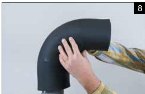
8 Завершите монтаж надеванием полученной детали плиты на трубопровод, склеиванием продольного стыка и соединением торцов с дальнейшей изоляцией KAIFLEX на трубопроводе.
